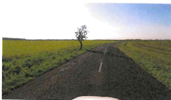
Mozaikové trhliny, ztráta kameniva z nátěru
