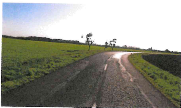
Hlubková koroze, podélné trhliny, vysprávký
