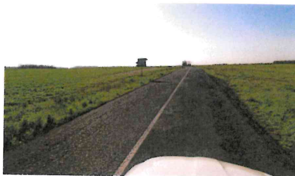
Hlubková koroze, mozaikové trhliny, vysprávk
