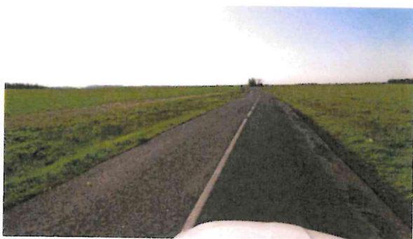
Ztráta kameniva z nátěru, mozaikové trhliny
