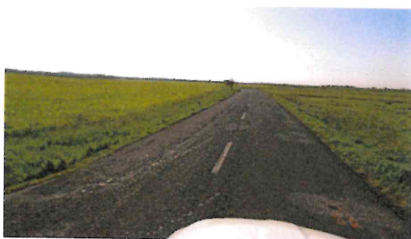
Mozaikové trhliny, ztráta kameniva z nátěru, vysprávk
