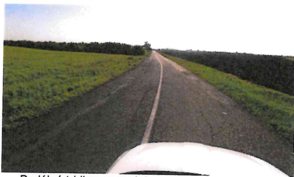
Podélné trhliny, vysprávký
