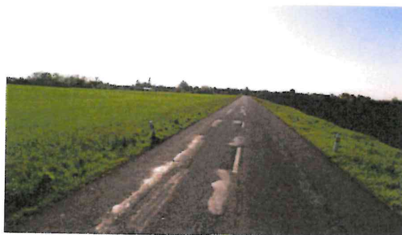
Hlubková koroze, vysprávký, mozaikové trhliny
